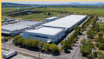
京ヶ瀬工場（新潟県阿賀野市）
