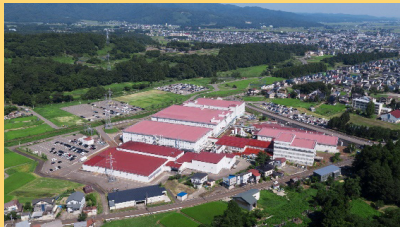
新井工場（新潟県妙高市）
