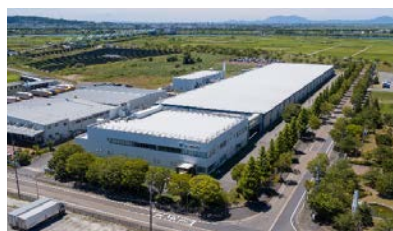
京ヶ瀬工場（新潟県阿賀野市）
