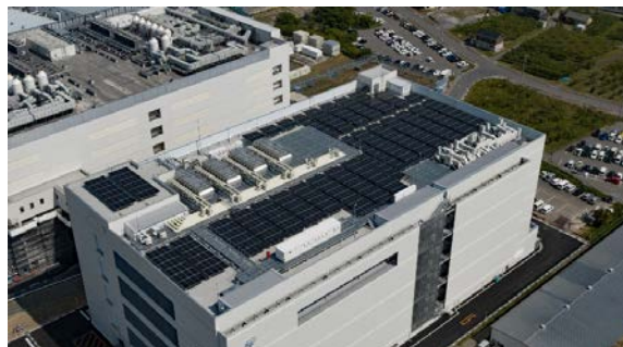
（高丘工場（長野県中野市）E棟）
