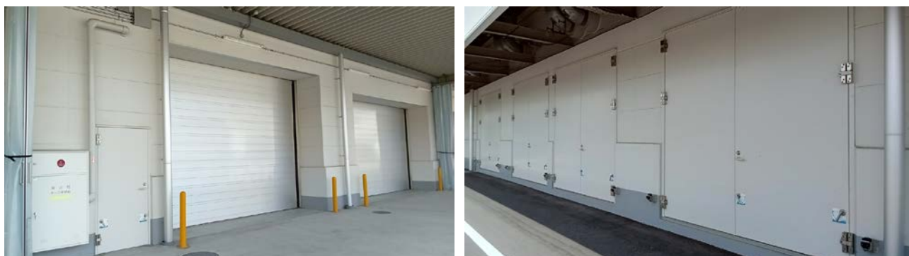
〔止水シャッター（左）、止水扉（右）（千曲工場）〕
