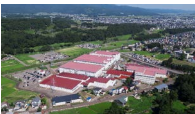
新井工場（新潟県妙高市）
