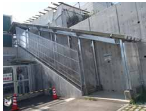
〔点検ルートへの屋根および防雪フェンスの設置〕
