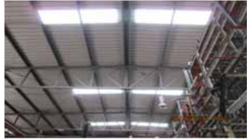
〔天井の透明プレート〕
