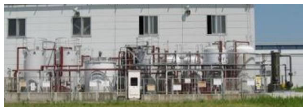
〔京ヶ瀬工場 タンクヤード改修〕
