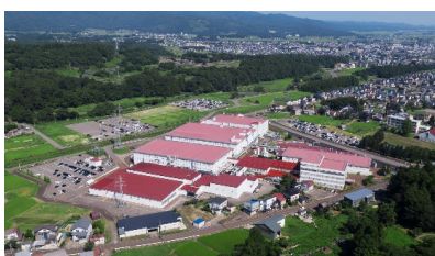
新井工場（新潟県妙高市）
