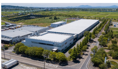
京ヶ瀬工場（新潟県阿賀野市）
