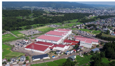
新井工場（新潟県妙高市）
