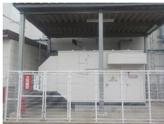
〔非常用発電機(新井工場)〕
