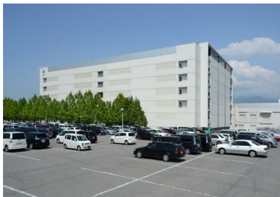
設備導入予定の高丘工場 J 棟
