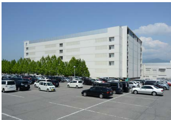
設備導入予定の高丘工場 J 棟
