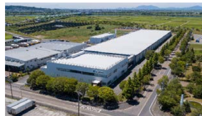
京ヶ瀬工場（新潟県阿賀野市）
