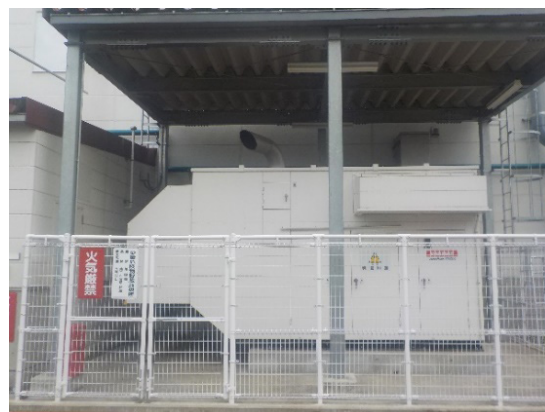
〔非常用発電機(新井工場)〕
