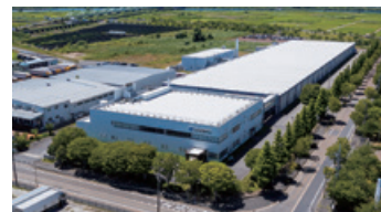
京ヶ瀬工場（新潟県阿賀野市）
