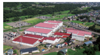
新井工場（新潟県妙高市）
