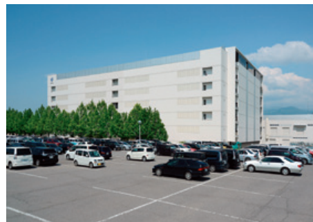
生産ライン導入予定の高丘工場J棟
