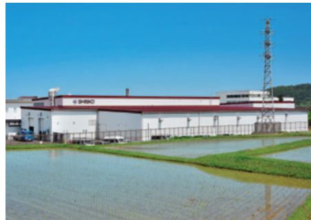
新井工場新棟
