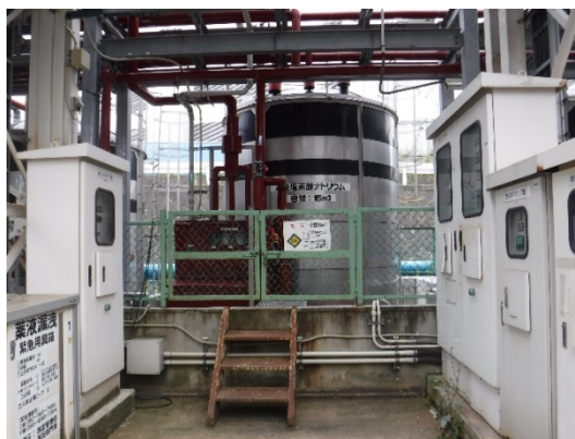
〔薬液タンク更新（高丘工場）〕
