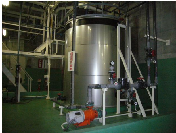
〔新井工場 薬品タンク更新〕
