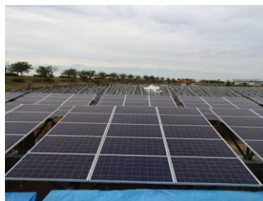
〔京ヶ瀬工場に建設中の太陽光発電システム〕
