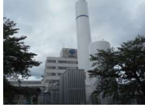
〔窒素供給設備〕
