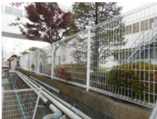
〔落下防止のフェンス設置〕
