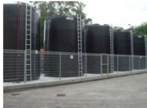
(大型貯水タンク)
