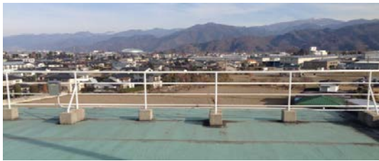
〔フェンス取り付け後の屋上〕
