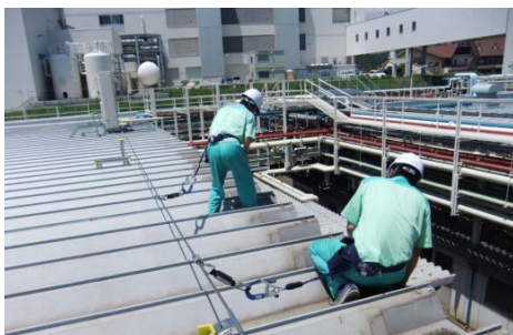
〔セイフスライダー着用による屋根での作業〕
